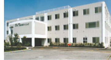
慶寿会クリニック 新築工事
