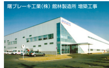
曙ブレーキ工業(株) 館林製造所 増築工事
