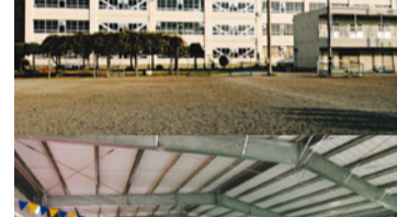
八潮市立八条中学校校舎他 耐震補強及び大規模改造工事
