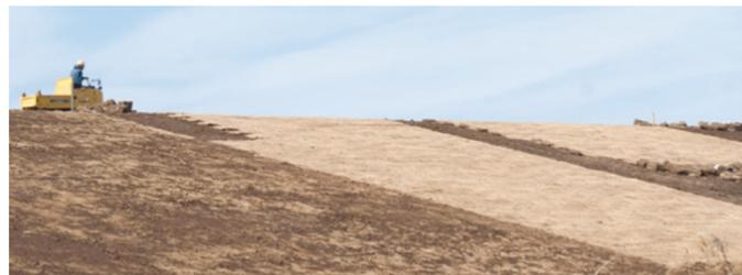
▲盛土をしたあと、バックホーで整地をして、堤防の斜面に芝を植え付けていく。若葉の頃には、一面の緑に変わるはず
