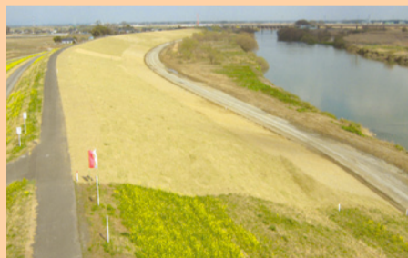
▲写真左が完成直後の堤防。写真右のように、築堤の盛り土に必要な土取り場には、掘削と同時に自然に近い湿地環境を作り出す整備も行いました。中央から右に人口の水たまりが見えます
