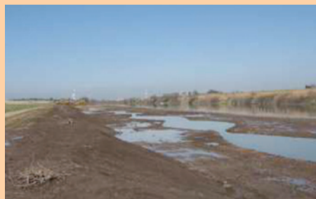
▲写真左が完成直後の堤防。写真右のように、築堤の盛り土に必要な土取り場には、掘削と同時に自然に近い湿地環境を作り出す整備も行いました。中央から右に人口の水たまりが見えます
