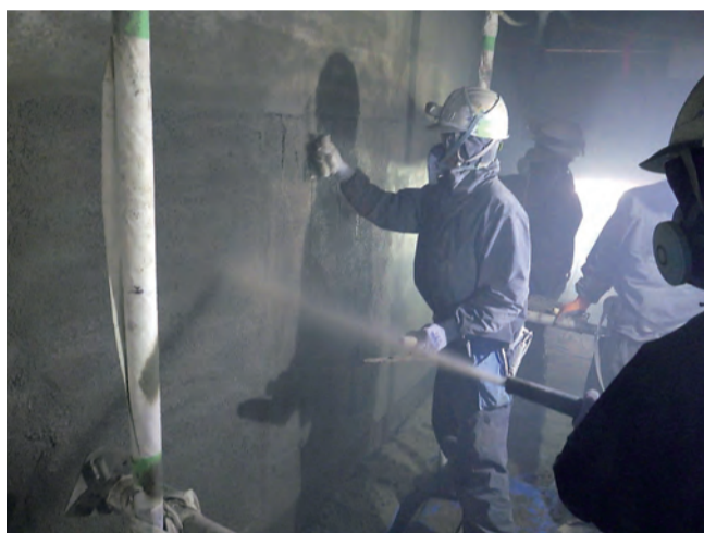
▲粉塵やセメント材の飛沫などを浴びないように、重装備で作業。ノズルで液体状になったセメント材を吹き付ける端から（手前）、専門の左官職人が平滑になるようにコテ仕上げを施す（奥）。出た粉塵は、写真には写っていないが、大型の集塵機で吸い上げて処理している。外に飛散させないための配慮
