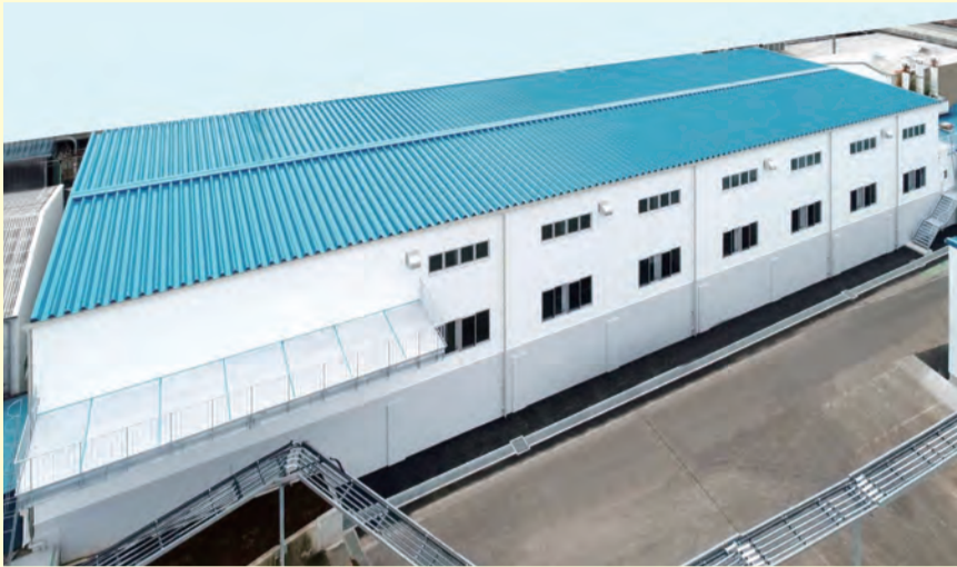
▲完成しためっき工場の外観。手前のベランダ状の突出部に「スクラバー」と呼ばれる有害ガス処理と排風のための装置が据え付けられる。
