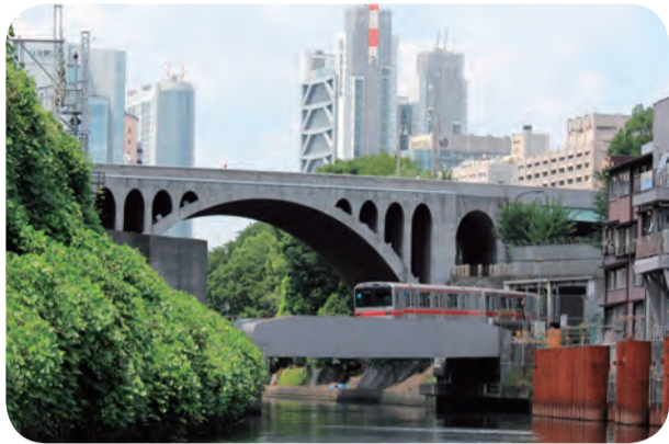
▲施工前の聖橋全景。近代日本建築の粋が表現された橋の美しさを、決して補修工事で損ねることのないよう、細心の注意を払って作業は行われた
