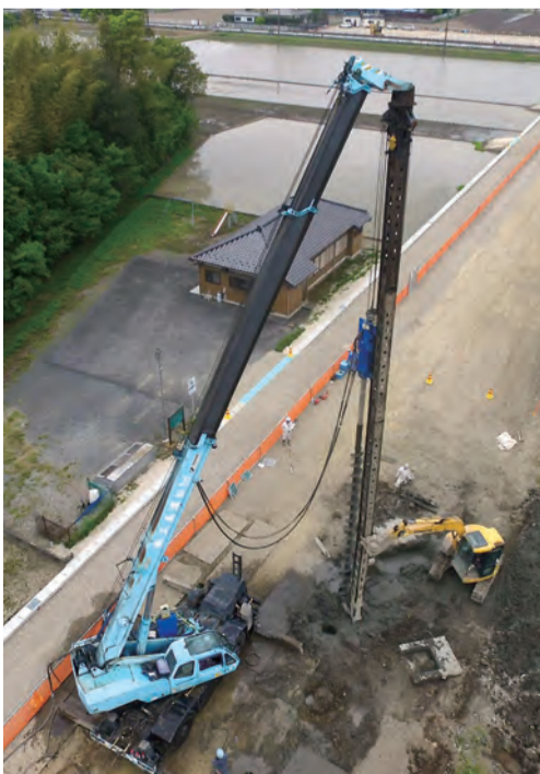
▲防火水槽設置のための杭打ち工。軟弱地盤を強化する規模の大きな工事
