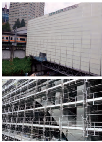
▲命綱ともなる頑丈な足場を組んで、橋全体をすっぽりと覆うところからスタートする。カバーは工事中の景観を守りつつ、吹付け作業で出る粉塵を飛散させない役を果たす
