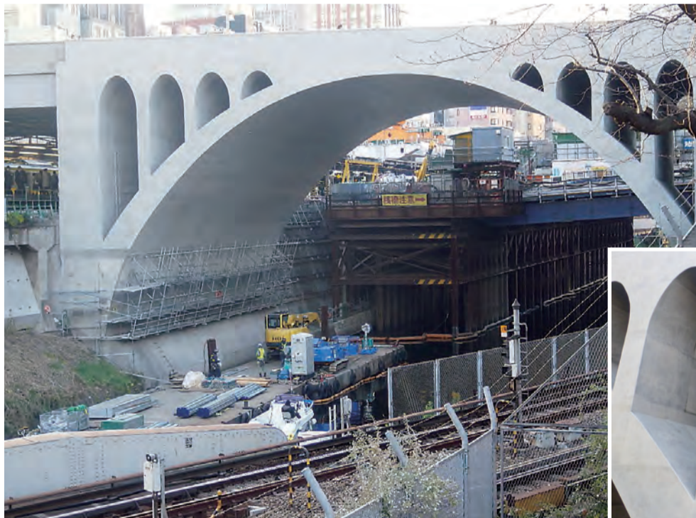
◀足場と囲いが取れ、まもなく竣工。同工法を扱うことのできる他県の会社と共同で、昨年9月からこの2月までの半年間、2班ずつ昼夜交代制で乗り切った。奥の現場はJR御茶ノ水駅の改修工事のもの
