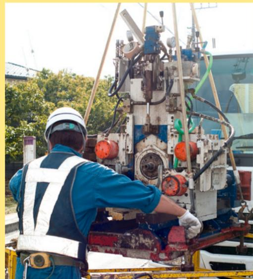
▲作業が終わると機械をクレーンで吊り上げてトラックに乗せ、また他の立坑へと移動し、設置します
