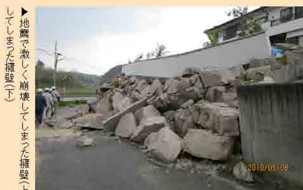
▶地震で激しく崩壊してしまった擁壁(上)と、地滑りを起こし、40センチほども断裂
