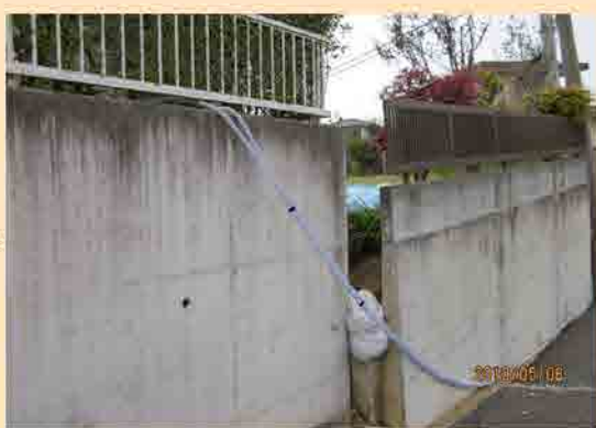
▶地震で激しく崩壊してしまった擁壁(上)と、地滑りを起こし、40センチほども断裂
