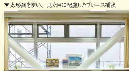
▼丸形鋼を使い、見た目に配慮したプレース補強
