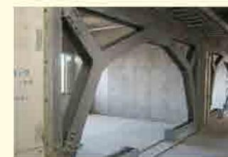
▲見た目からはわからないよう、壁の内部に施工したプレース補強
