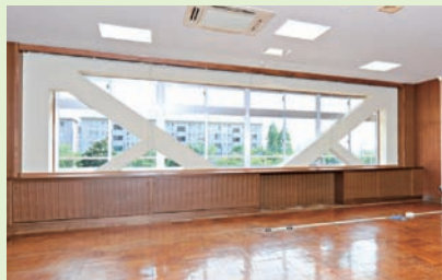
▲ 耐震補強用の鉄骨ブレースを壁面に入れ込み、化粧仕上げ。三郷市立彦糸中学校、さいたま市立城北小学校の工事より
