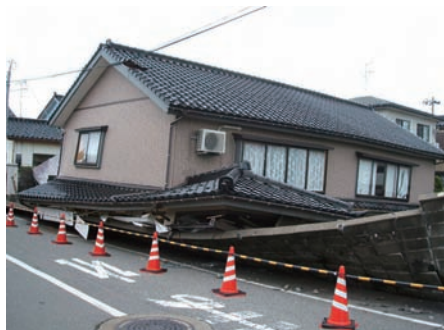
▲最大震度6強を記録した2007年の新潟県中越沖地震の倒壊家屋。1階はほぼ崩壊した一方で、2階は比較的原形をとどめるケースが多かった。
