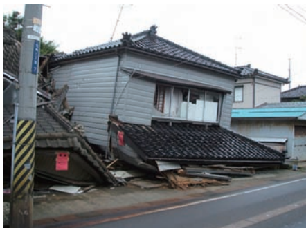
▲最大震度6強を記録した2007年の新潟県中越沖地震の倒壊家屋。1階はほぼ崩壊した一方で、2階は比較的原形をとどめるケースが多かった。
