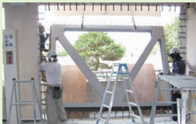
▲ 耐震補強用の鉄骨ブレースを壁面に入れ込み、化粧仕上げ。三郷市立彦糸中学校、さいたま市立城北小学校の工事より
