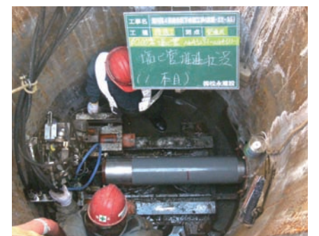
▲始点と終点に立坑を掘るだけで、地表を掘り返さない推進工法。廃土も騒音も少ない環境重視の工法だ。写真上は、立坑に掘進機を入れて油圧ジャッキで掘り進める作業の様子。左は巨大な掘削機を使って、立坑そのものを道路に空ける作業工程。推進工法だけで総長1kmほど、立坑を21本も掘る大工事だった
