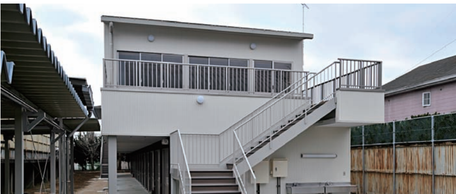
▲完成した2階弓道場(写真上)と1階部室棟を含む外観(写真下)。それまで部室がなかった春日部女子高校の生徒さん達にも大変喜んでもらった本工事は、まさに感動創造建設会社の面目躍如。小松原参与は学校から感謝状を頂戴するという、異例ながらも嬉しい結果に
