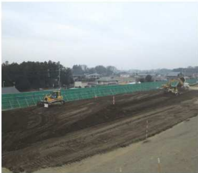
▲完成した川妻堤防の強化工事。土が露出している部分が新たに盛土をし、堤防を太らせたところ
