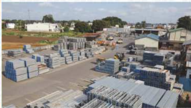
▲敷地には仮設工事のための資材一式がズラリ。種類ごとに山のように積み上げられ出荷を待っています
