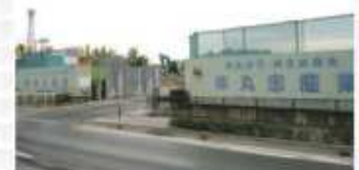
▲再生骨材工場の外観。騒音と粉塵の対策用に、広い外周をぐるりと壁が取り囲む
