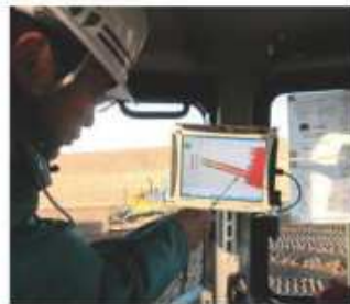
▲「GPSを用いた締め固め管理」の様子。ブルドーザーの踏み固め跡が回数によってモニターに色分け表示され、それを見ながら踏み足りない箇所がないよう作業を行う
