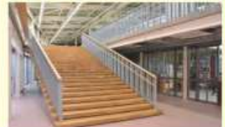
▲段差をあえて小さくした階段に座ること、講義や講評会などにも有効活用される吹き抜けのホール。天井裏をはじめとする各部が露わになっていることがわかる。
