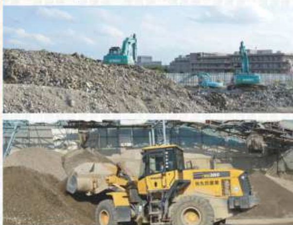
▲コンクリートやアスファルトの廃材を真上を適切な大きさで砕いて再生材に(写真左)
