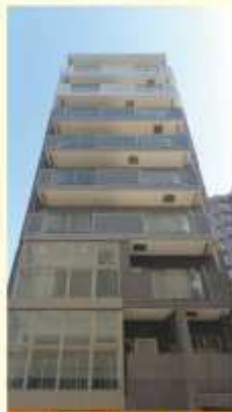
鎌ヶ谷市新鎌ヶ谷駅前マンション 千葉駅線から徒歩10分、西武池袋線から徒歩10分、池袋駅
