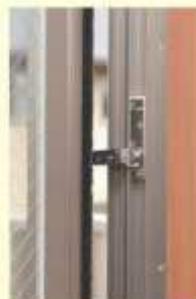
▲窓は片開きに固定、開く側には指はさみ防止の器具を全窓に設置した。室内ドアもすべてに同様の配慮がある
