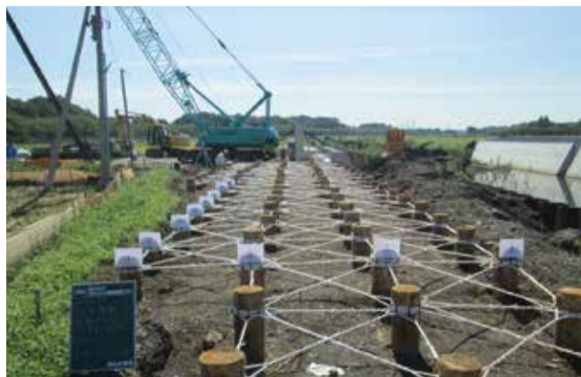
▲長い木の杭を土中に打ち込み頭部を連結するパイルネット工法で地盤改良。予測通りの強度を発揮、護岸ブロックも美しく積み上がった
