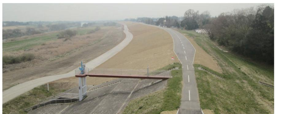
▲今回表彰を受けた現場のひとつである「H24築比地中地区築堤工事」より。盛り土をし堤防を築く工事や、堤防断面積を太らせる強化工事は、河川の氾濫を防ぐなど私たちの暮らしの安全を守っている
