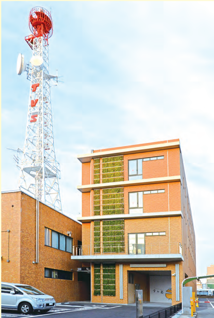
◀本社社屋の隣に完成した別館。5年後には4K・8K放送を見据えて全面更新された機器がこの2階に並び、マスター業務の拠点となる
