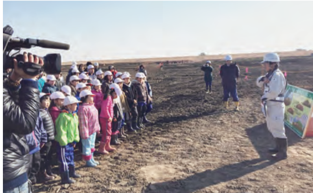
▲堤防工事が暮らしの安全を守る工事と知って、じっと聞き入る児童たち
