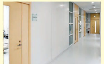
▲いずれマスター室となる2階は、現段階では会議室や応接室などとして静かに待機。特殊仕様の床は、なんと厚み50cm。直径10cm近くにもなるケーブル類がその空間に多数這うことになる
