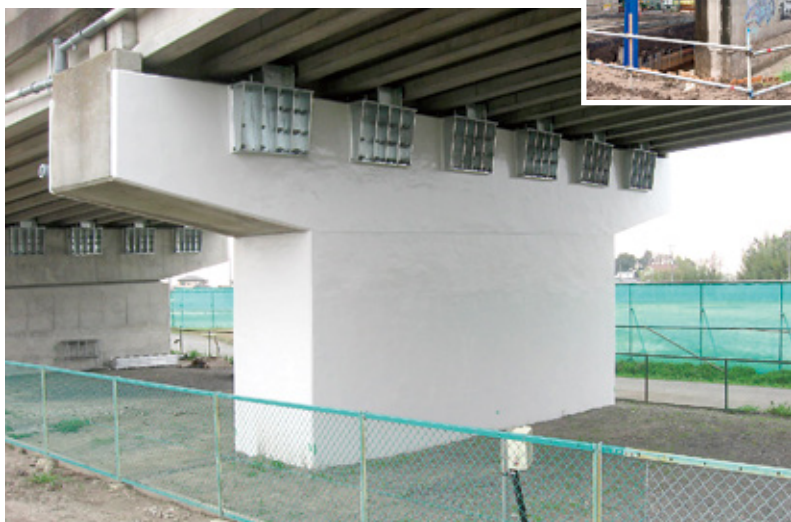
▲橋脚の耐震補強工事にて施工前(上)と、乾式吹付工法の施工後(左)。従来の方式が苦手とする悪条件も何のその
