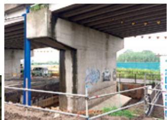
▲橋脚の耐震補強工事にて施工前(上)と、乾式吹付工法の施工後(左)。従来の方式が苦手とする悪条件も何のその
