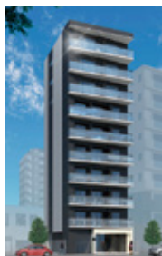
日本橋浜町 RC造10階建
