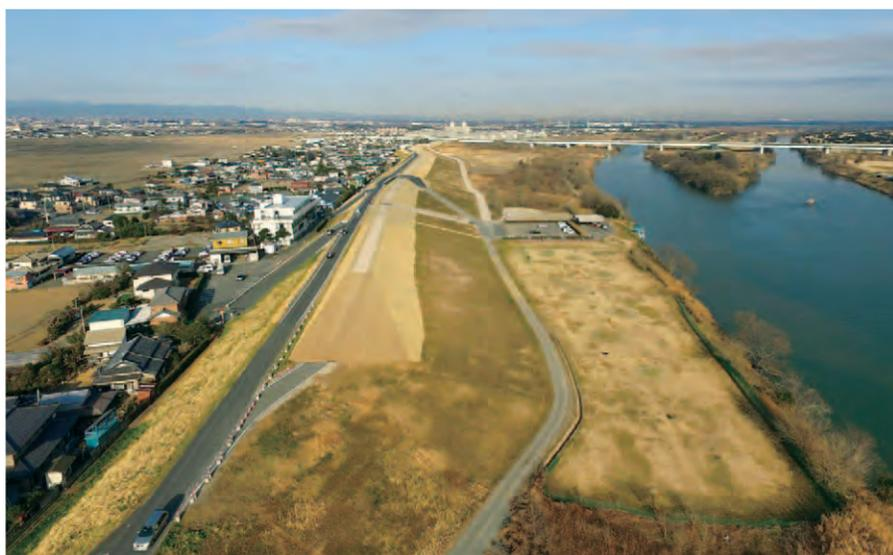
▲川越市古谷本郷に築かれた荒川の堤防。旧堤防の上に、さらに高く築堤する工事だった
